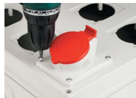
Монтаж розетки на 32 А
